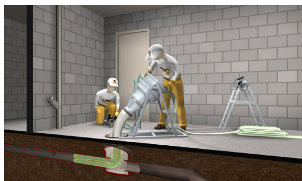
Figure 2 : Calibration de la gaine avec rouleaux de calibration Figure 3 : Inversion avec RS LinerGun ®
