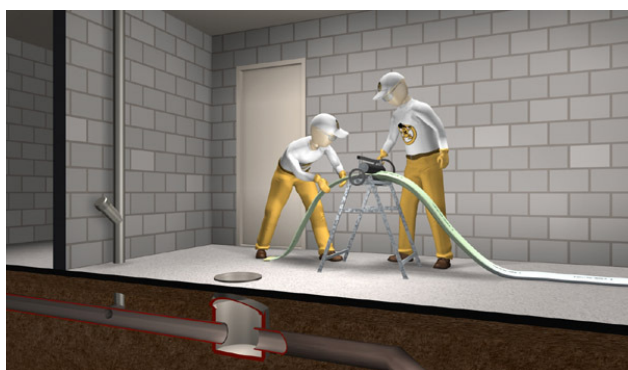
Figure 2 : Calibration de la gaine avec rouleaux de calibration Figure 3 : Inversion avec RS LinerGun ®
